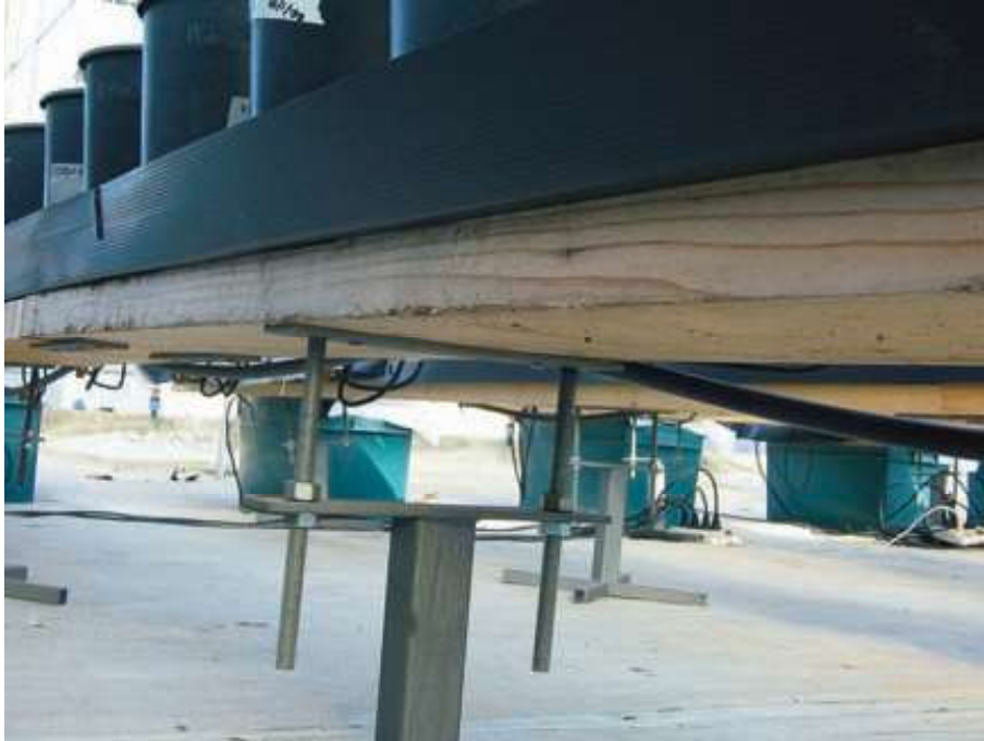
Foto 1 - Supporti in legno, che garantiscono la necessaria rigidità alle canalette in polipropilene, e sistema di sostegno regolabile in altezza (e lateralmente) per impostare le pendenze desiderate.
